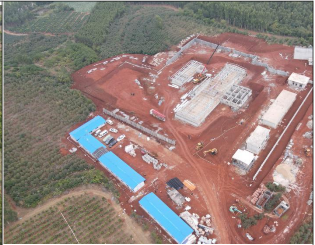
照片 2 项目区施工航拍 1
