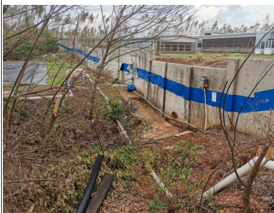
照片 5 项目区围墙 1
