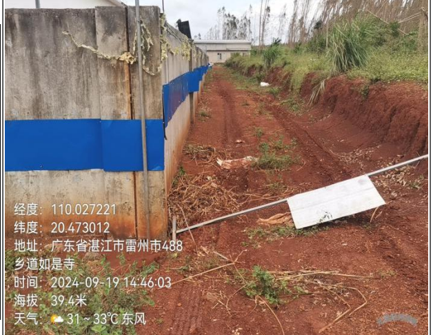
照片 6 项目区围墙 2
