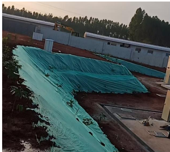
照片 8 项目区护坡 2
