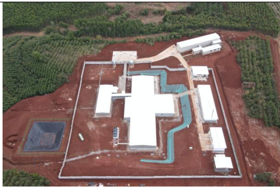
照片 3 项目区施工航拍 2
