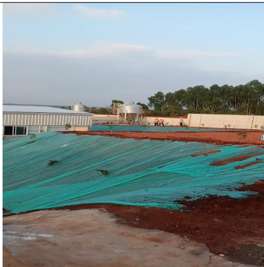
照片 7 项目区护坡 1
